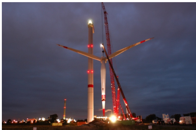
Figura 1 – Montagem de um aerogerador de pás de 61,5 metros (Extraído de http://www.lmgfiber.com/dz/A000228_32_4.jpg , acesso em 30 de Maio de 2007).
